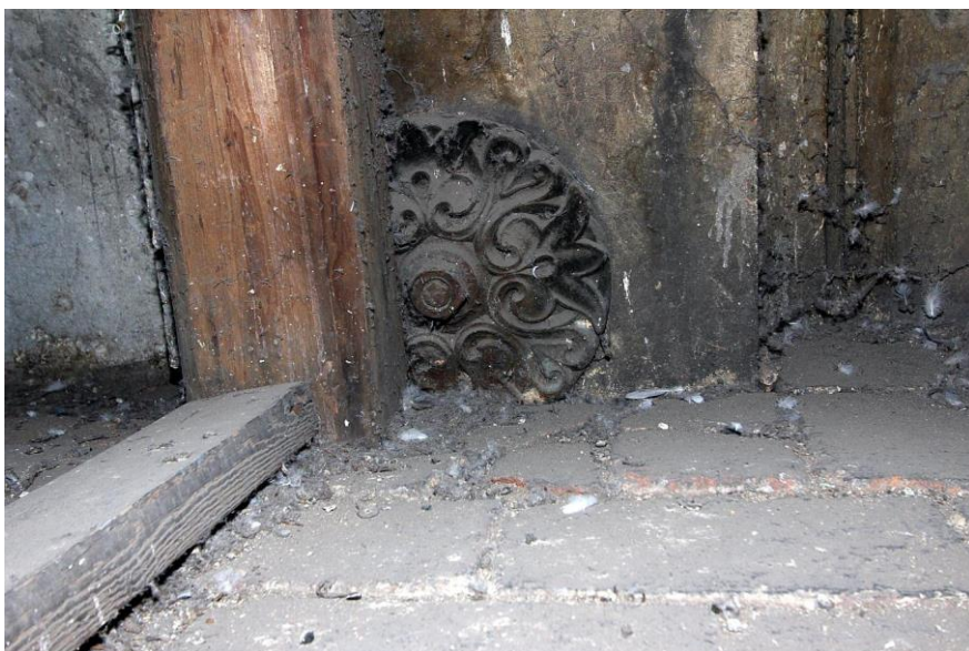
1568. Podkroví (3.N.P.), půda č. 2P86, detail kotevní závlače kleštiny.
